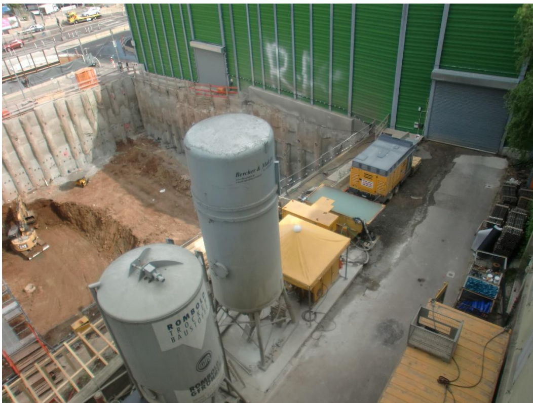
Abbildung 2: Blick auf das Baufeld bei Messende am 12.06.2017
