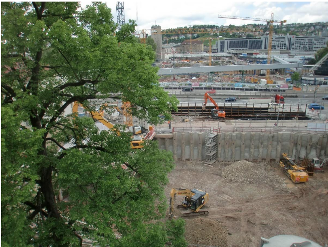
Abbildung 2: Blick auf das Baufeld bei Messende am 15.05.2017
