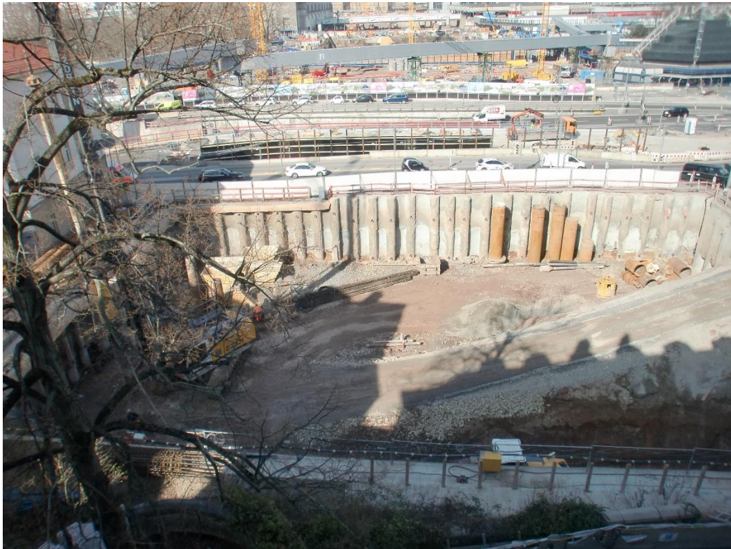
Abbildung 2: Blick auf das Baufeld bei Messende am 13.03.2017
