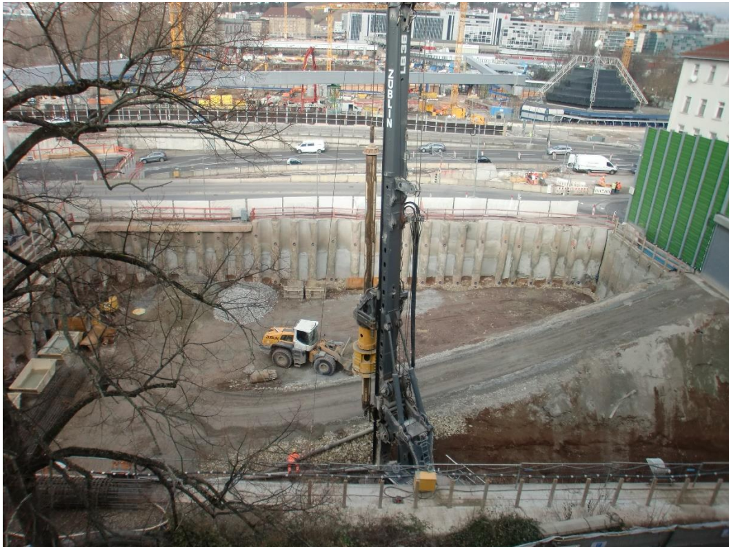
Abbildung 2: Blick auf das Baufeld bei Messende am 20.02.2017
