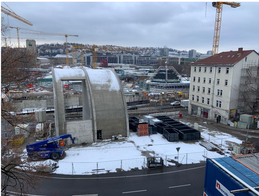
Abbildung 1: Blick auf das Baufeld bei Messbeginn am 23.01.2023
