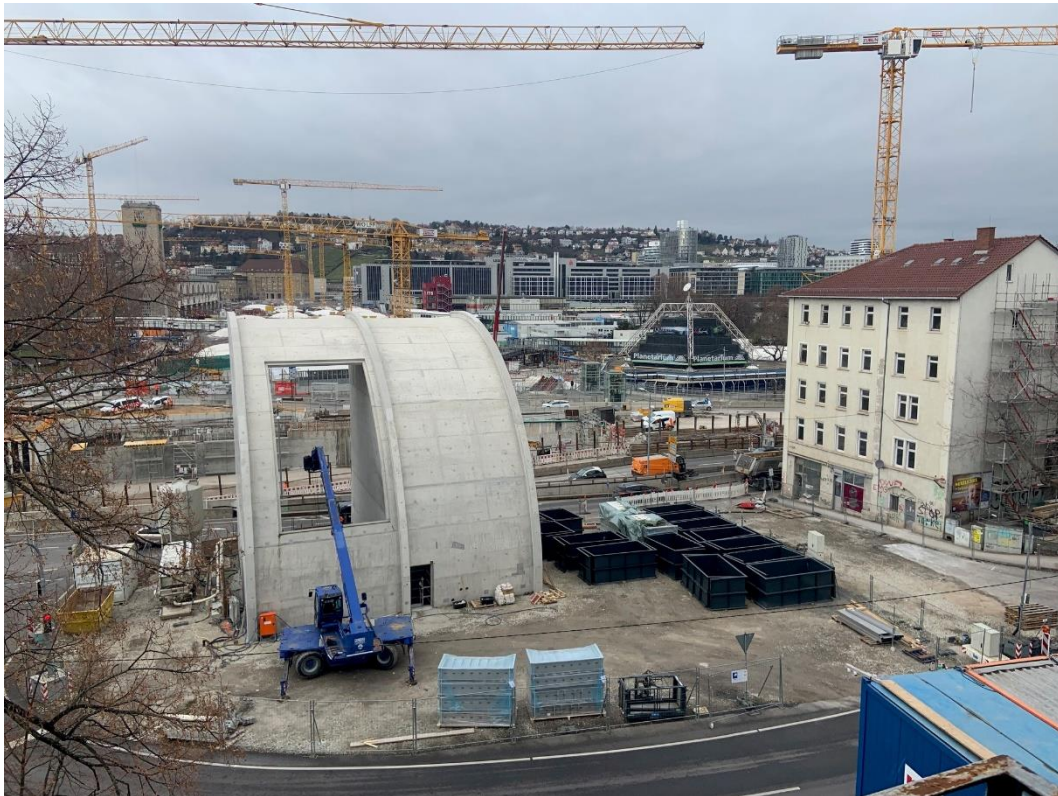
Abbildung 2: Blick auf das Baufeld bei Messende am bis 30.01.2023
