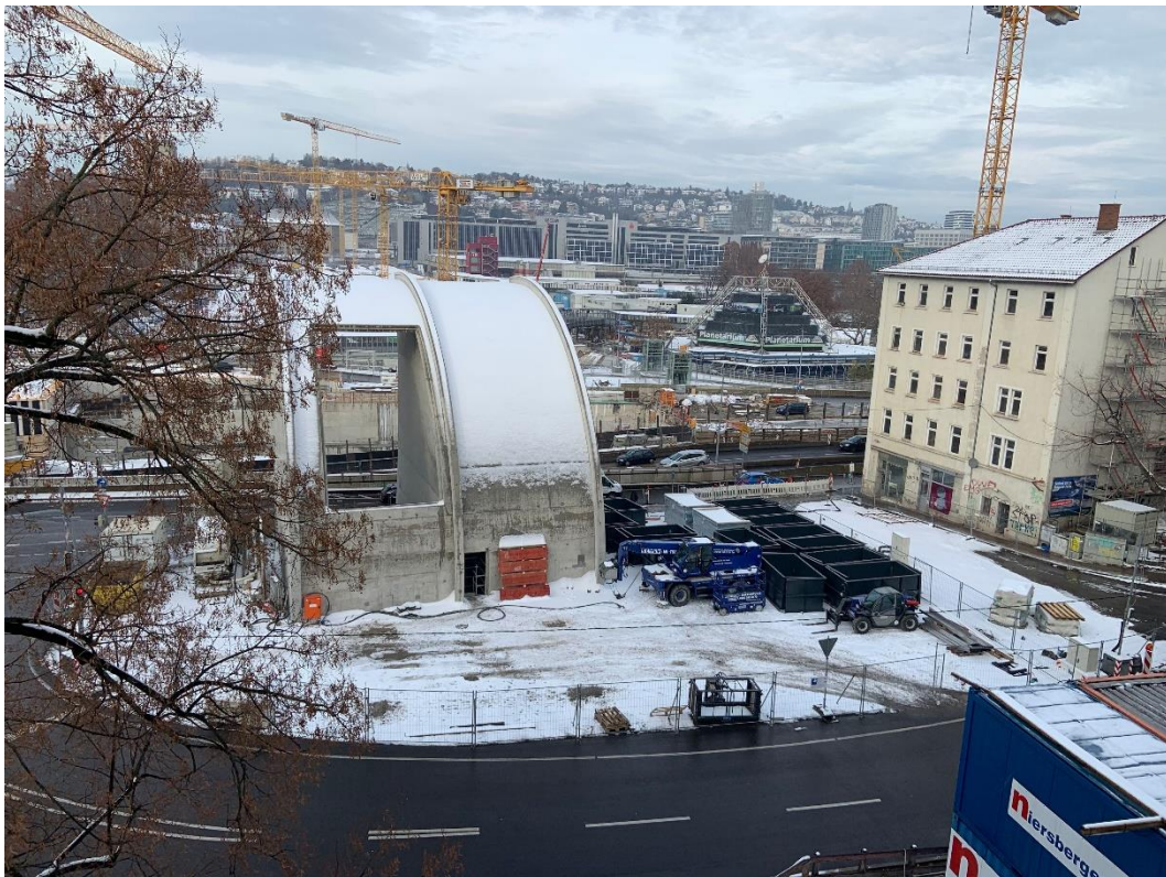
Abbildung 1: Blick auf das Baufeld bei Messbeginn am 19.12.2022
