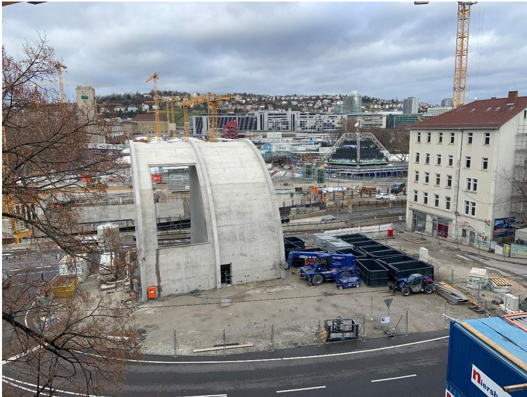
Abbildung 2: Blick auf das Baufeld bei Messende am bis 23.12.2022
