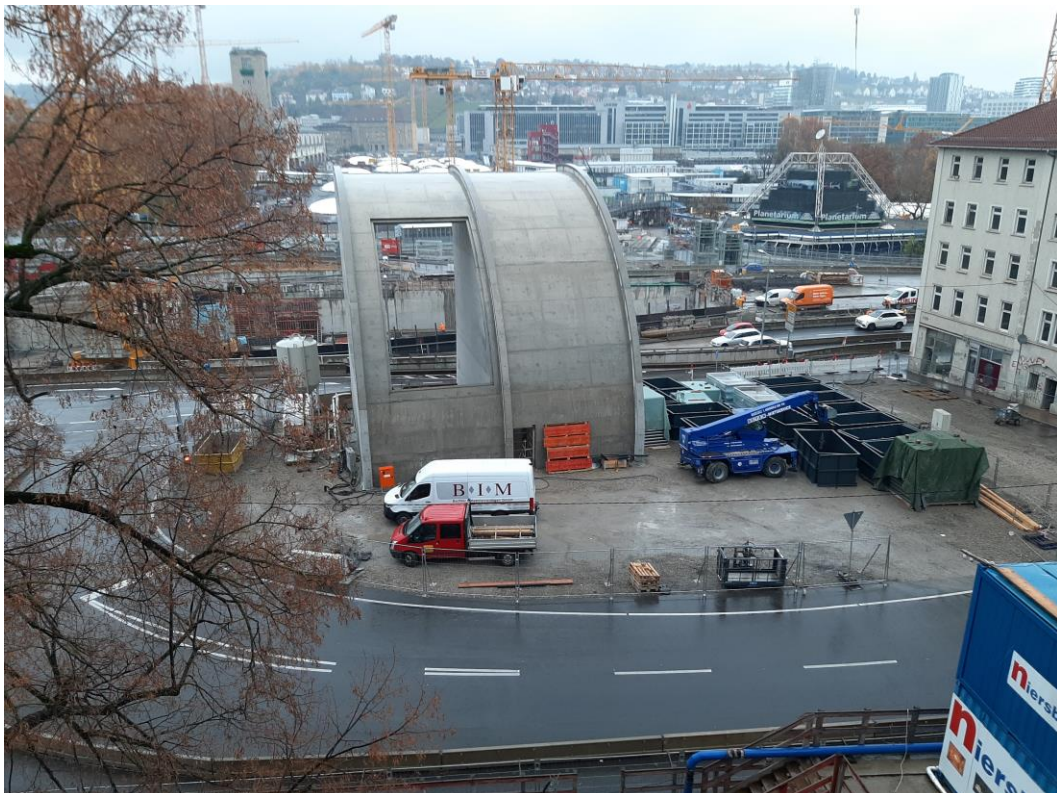
Abbildung 1: Blick auf das Baufeld bei Messbeginn am 28.11.2022
