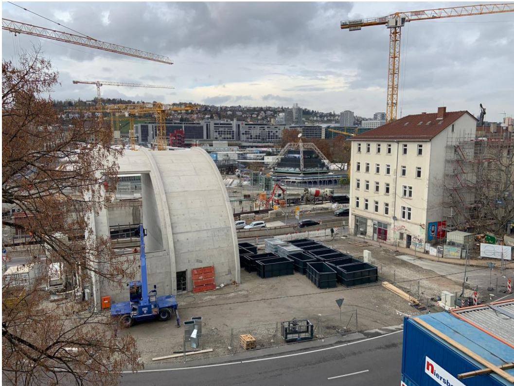
Abbildung 2: Blick auf das Baufeld bei Messende am bis 05.12.2022
