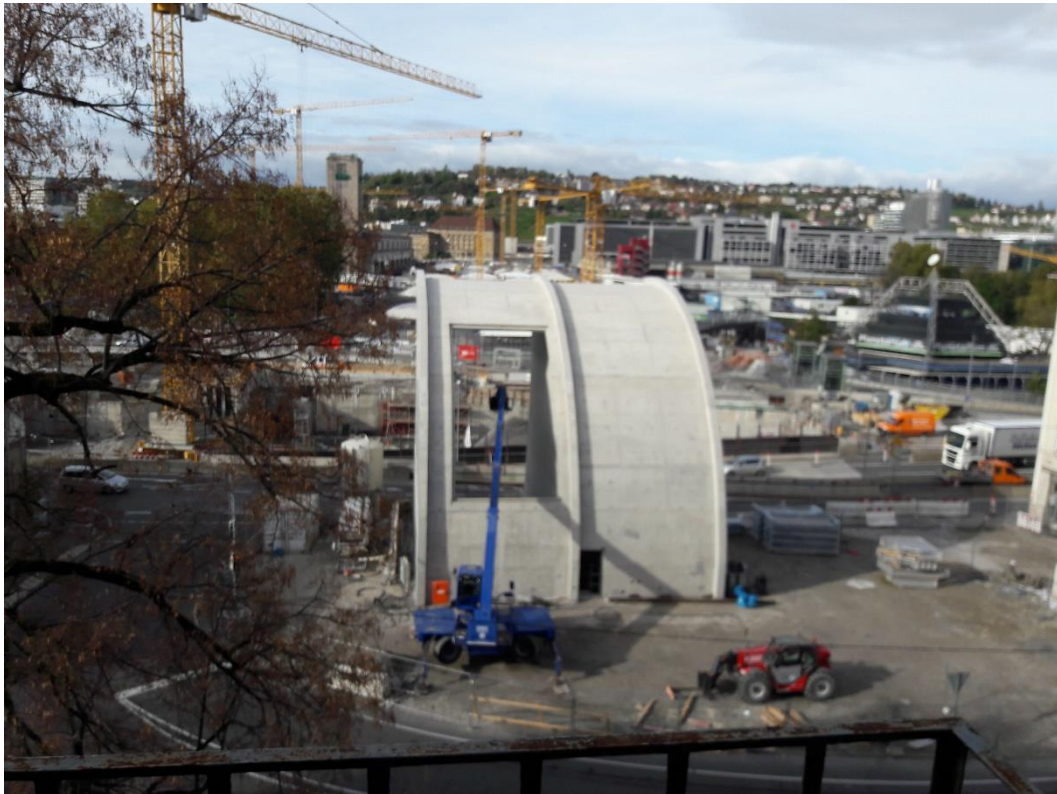
Abbildung 2: Blick auf das Baufeld bei Messende am bis 07.11.2022
