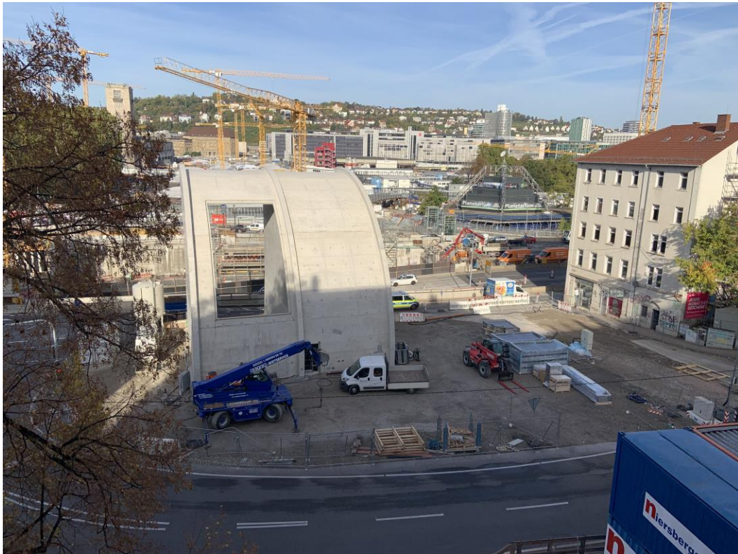
Abbildung 2: Blick auf das Baufeld bei Messende am bis 24.10.2022
