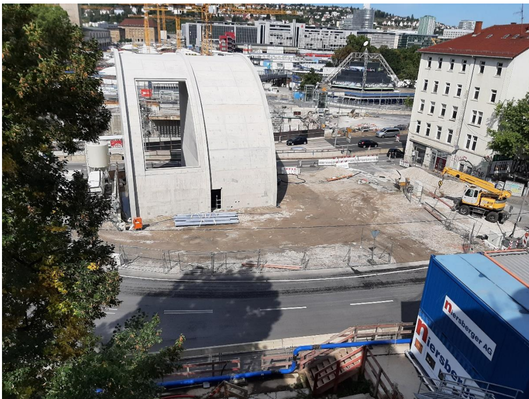
Abbildung 1: Blick auf das Baufeld bei Messbeginn am 26.09.2022
