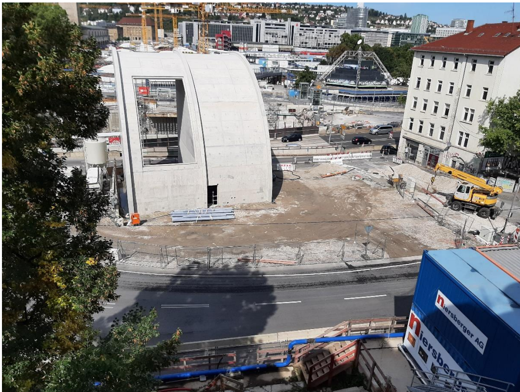
Abbildung 1: Blick auf das Baufeld bei Messbeginn am 06.09.2022
