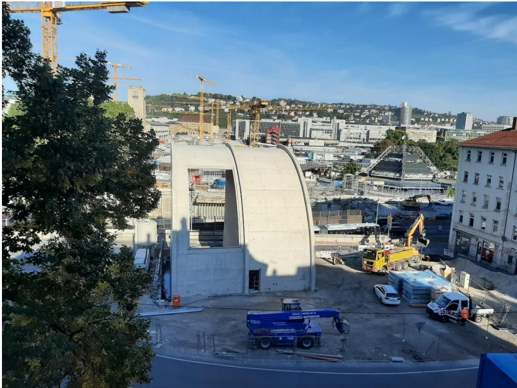
Abbildung 2: Blick auf das Baufeld bei Messende am bis 12.09.2022
