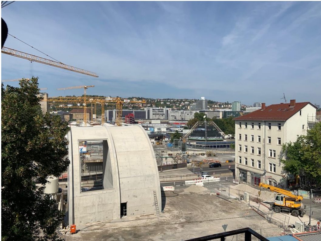
Abbildung 2: Blick auf das Baufeld bei Messende am bis 29.08.2022
