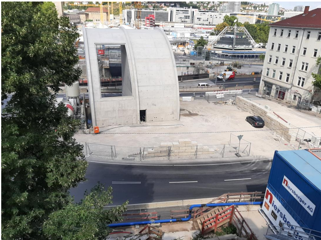
Abbildung 1: Blick auf das Baufeld bei Messbeginn am 15.08.2022
