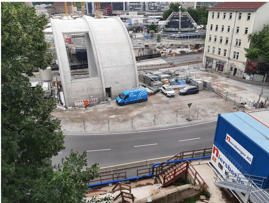
Abbildung 1: Blick auf das Baufeld bei Messbeginn am 26.06.2022
