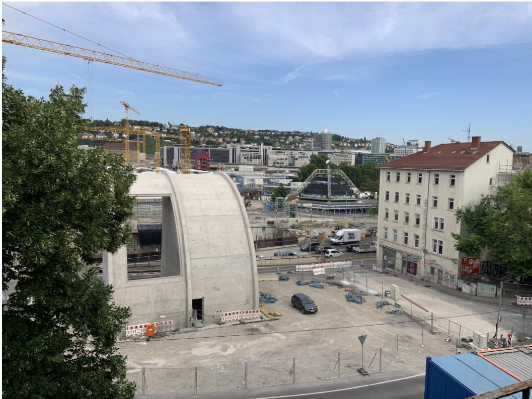
Abbildung 2: Blick auf das Baufeld bei Messende am bis 04.07.2022
