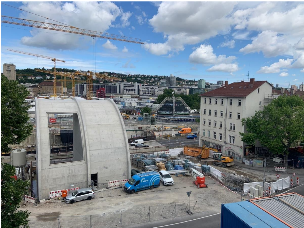
Abbildung 1: Blick auf das Baufeld bei Messbeginn am 06.06.2022
