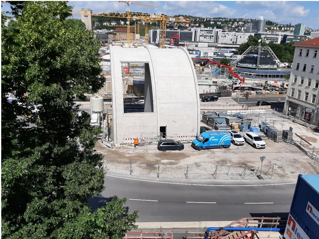
Abbildung 2: Blick auf das Baufeld bei Messende am bis 13.06.2022
