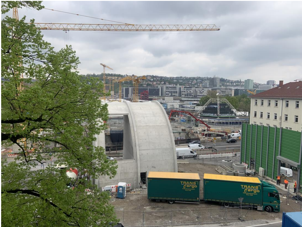
Abbildung 2: Blick auf das Baufeld bei Messende am bis 25.04.2022
