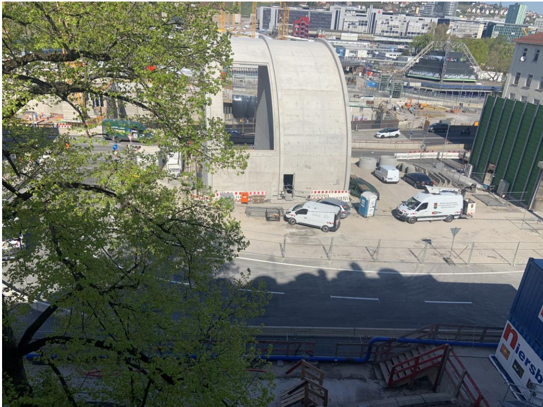
Abbildung 2: Blick auf das Baufeld bei Messende am bis 18.04.2022
