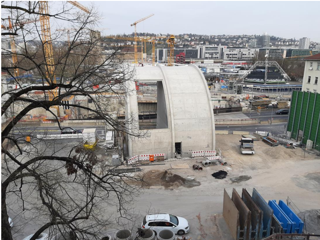
Abbildung 2: Blick auf das Baufeld bei Messende am bis 28.03.2022
