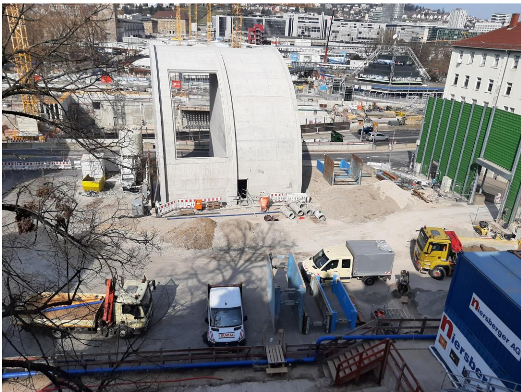
Abbildung 1: Blick auf das Baufeld bei Messbeginn am 21.03.2022
