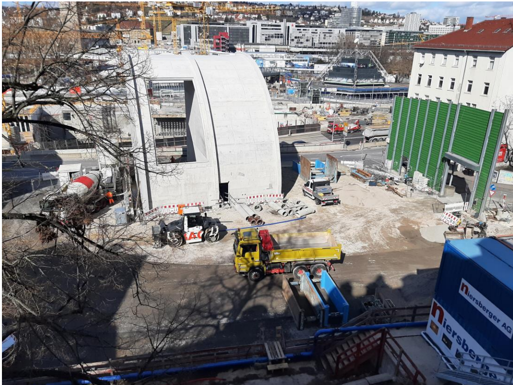
Abbildung 2: Blick auf das Baufeld bei Messende am bis 14.03.2022
