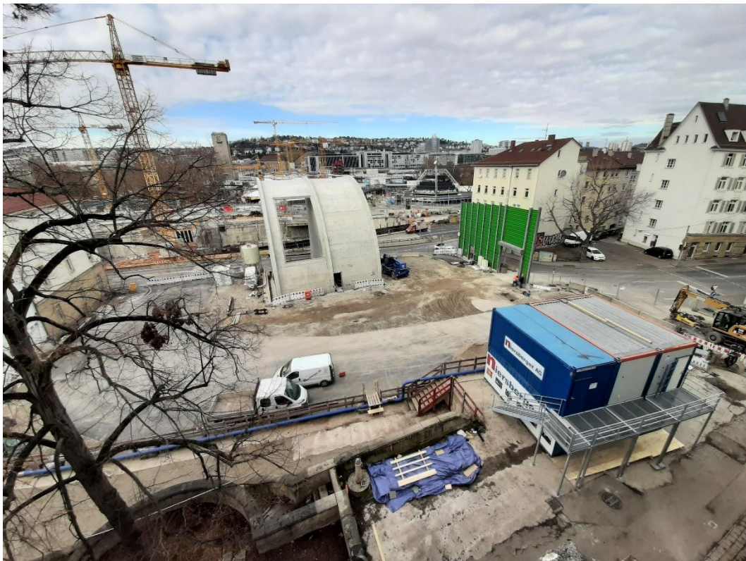
Abbildung 1: Blick auf das Baufeld bei Messbeginn am 14.02.2022
