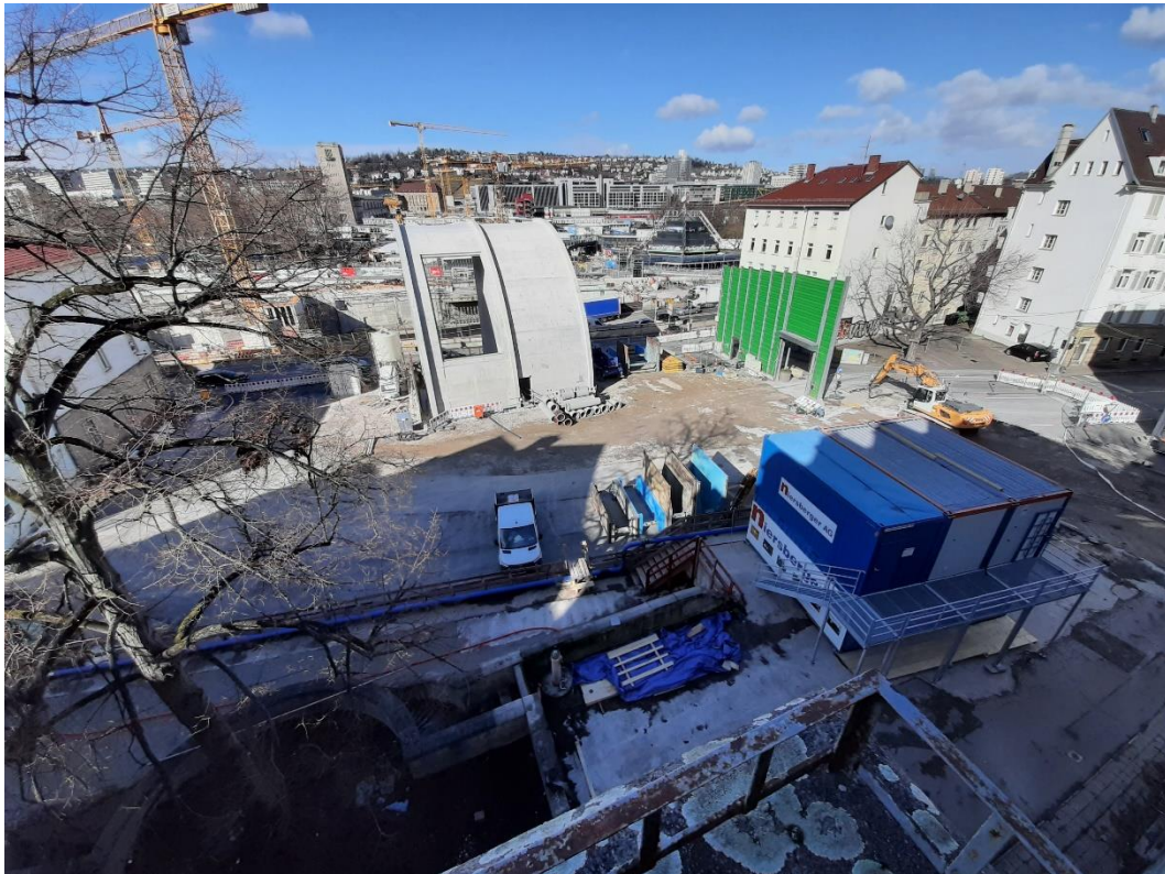
Abbildung 2: Blick auf das Baufeld bei Messende am bis 21.02.2022
