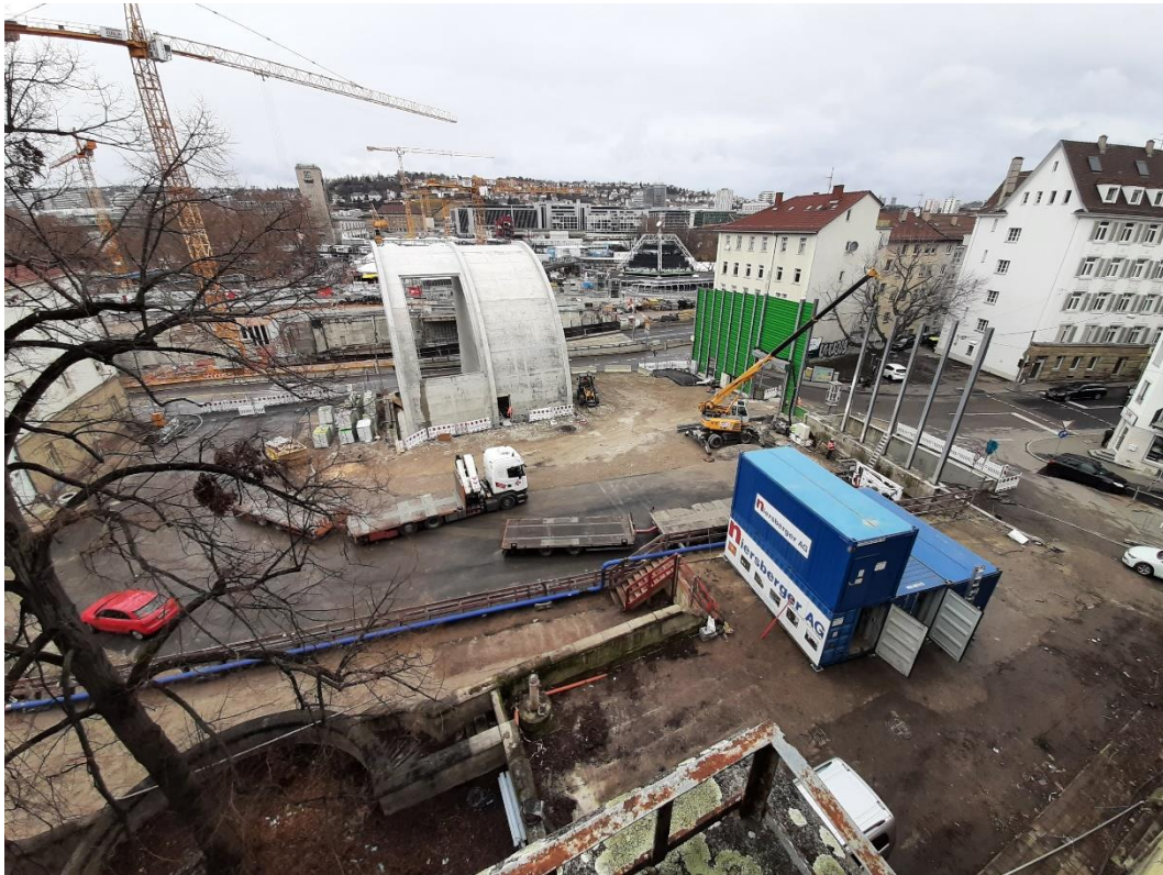
Abbildung 2: Blick auf das Baufeld bei Messende am bis 31.01.2022
