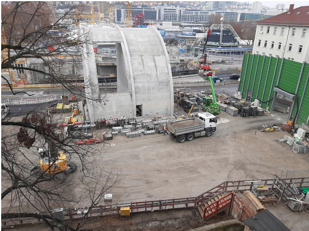
Abbildung 1: Blick auf das Baufeld bei Messbeginn am 13.12.2021
