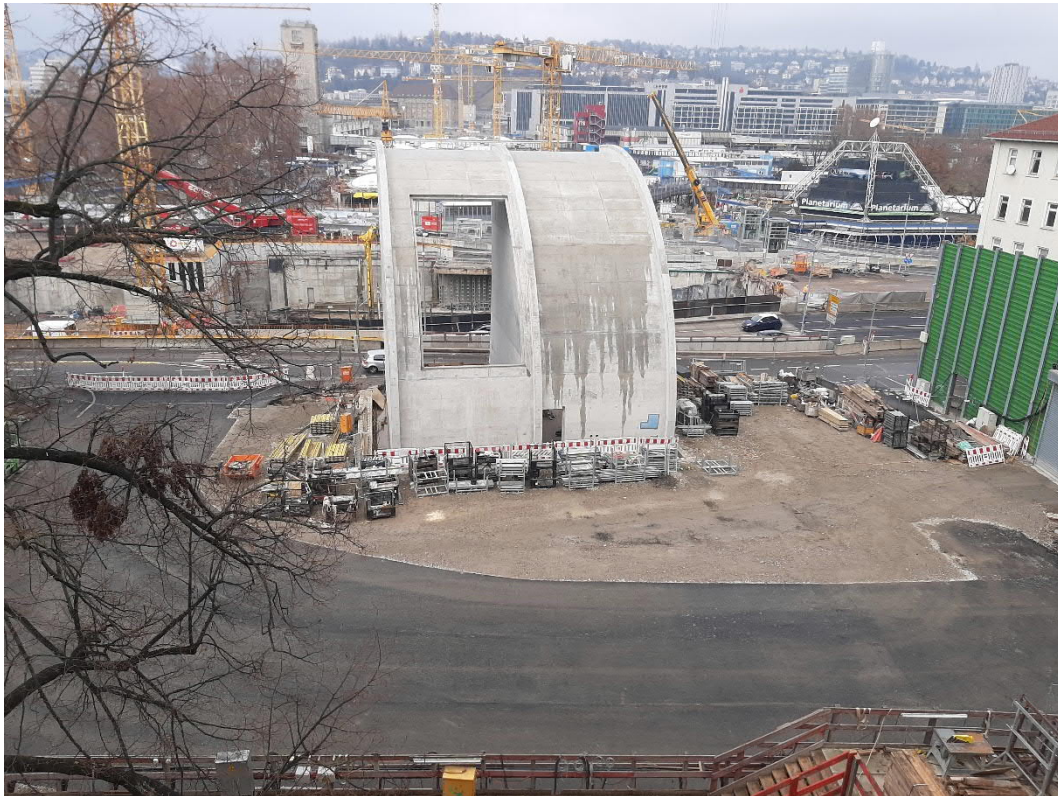
Abbildung 2: Blick auf das Baufeld bei Messende am bis 20.12.2021
