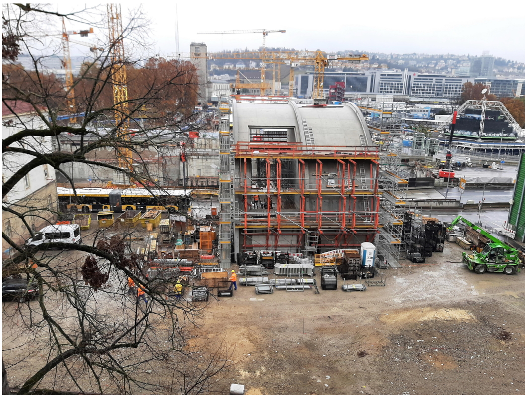
Abbildung 1: Blick auf das Baufeld bei Messbeginn am 22.11.2021
