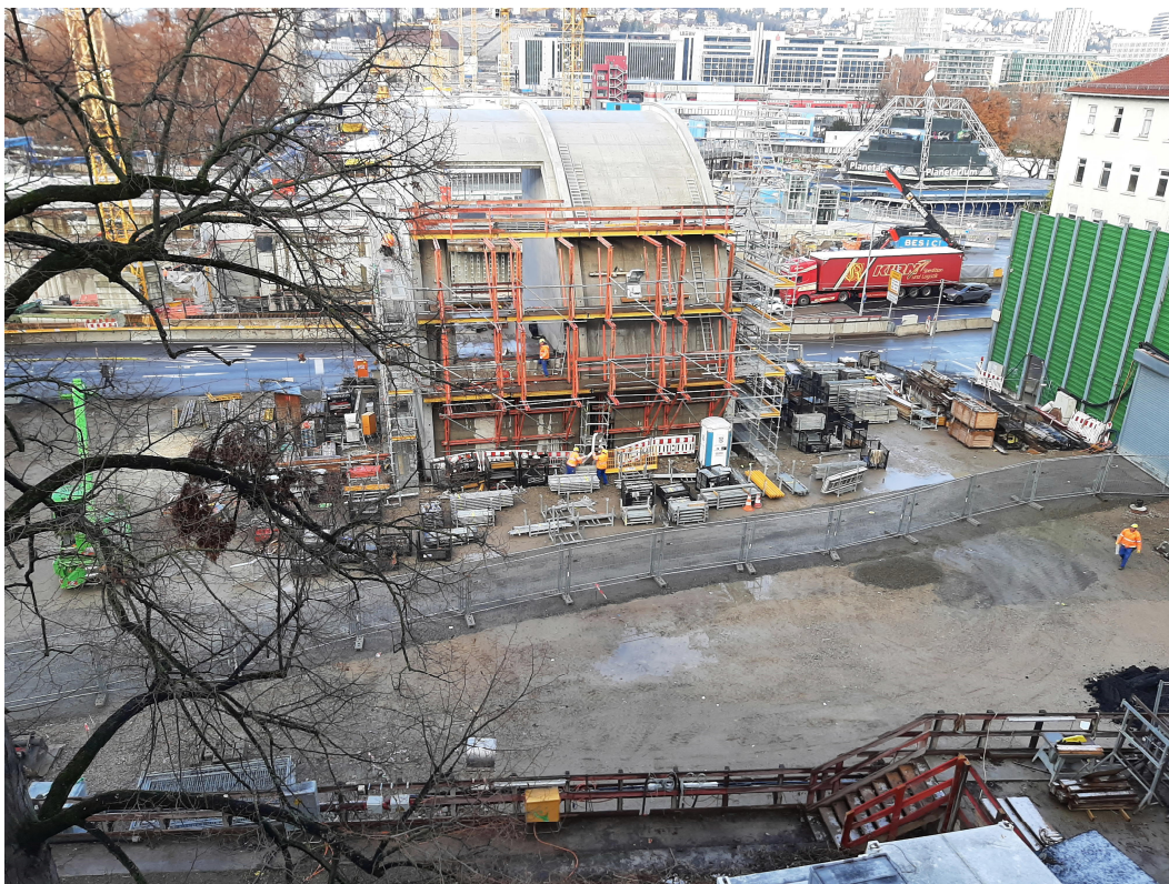
Abbildung 2: Blick auf das Baufeld bei Messende am bis 29.11.2021
