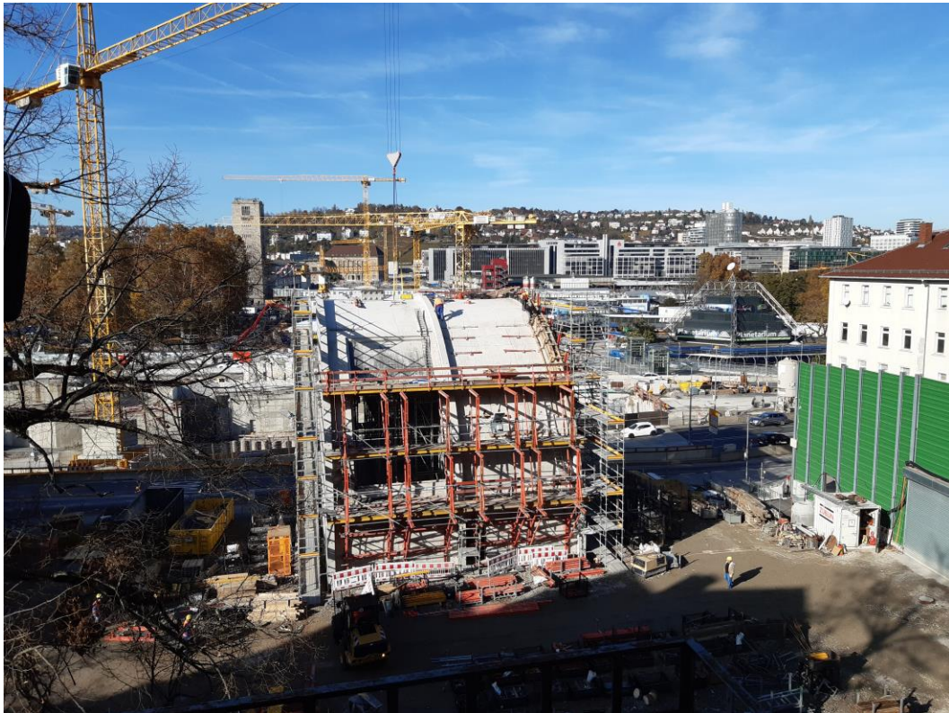
Abbildung 2: Blick auf das Baufeld bei Messende am bis 08.11.2021
