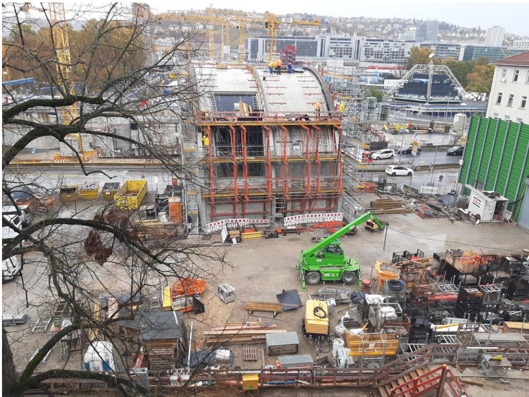
Abbildung 1: Blick auf das Baufeld bei Messbeginn am 11.10.2021
