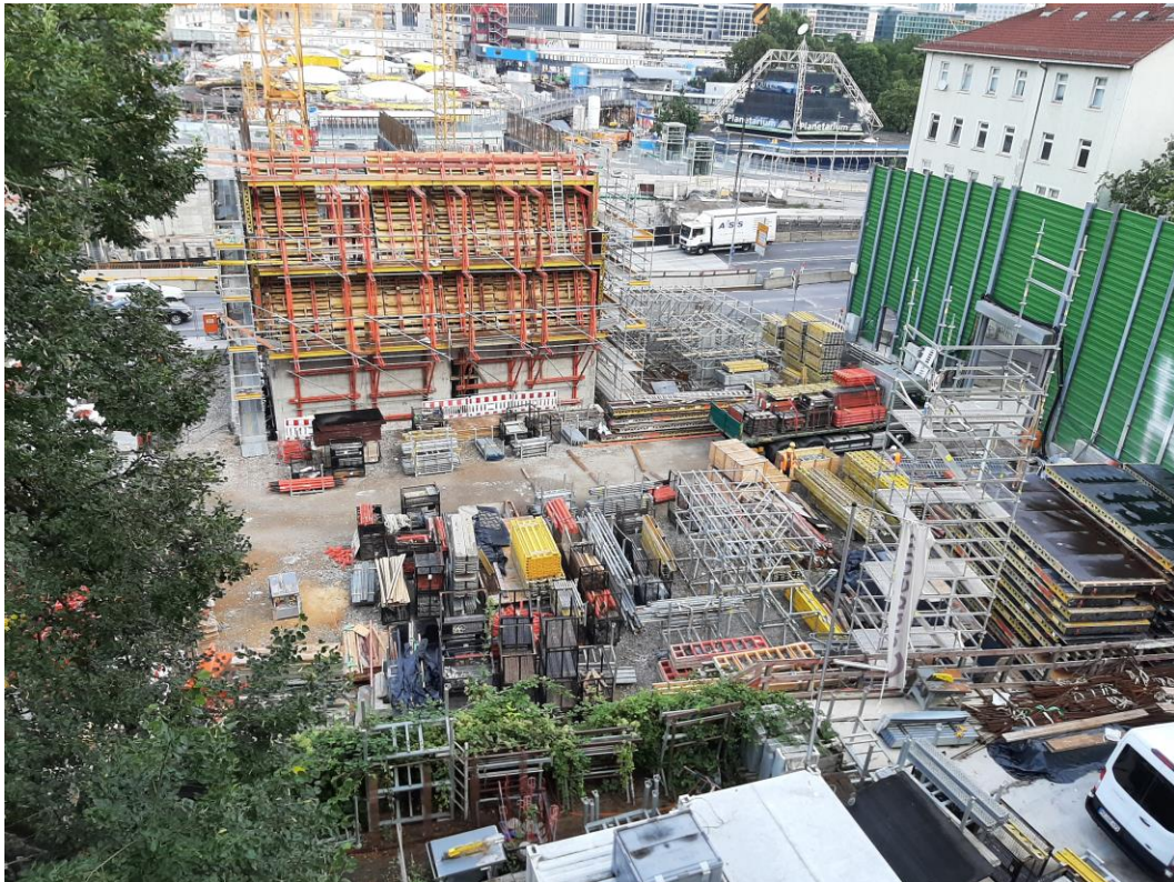
Abbildung 2: Blick auf das Baufeld bei Messende am bis 16.08.2021
