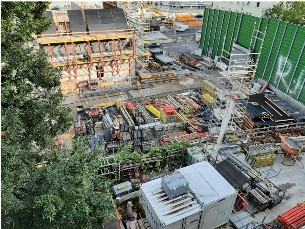
Abbildung 1: Blick auf das Baufeld bei Messbeginn am 26.07.2021
