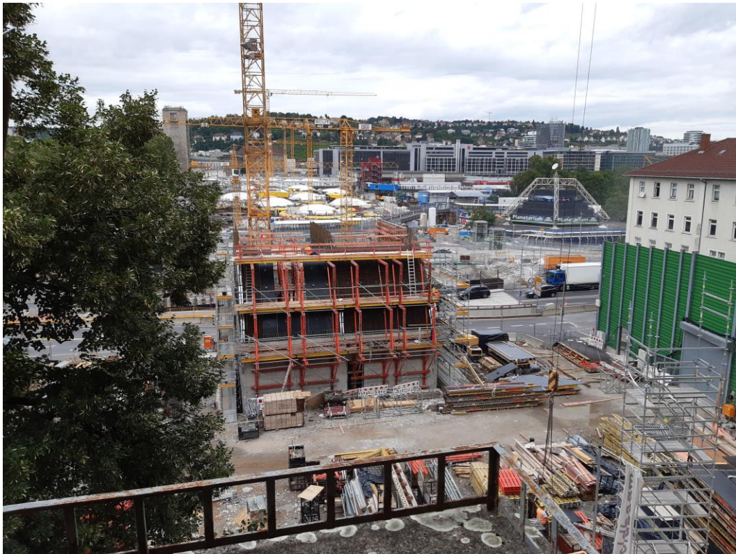
Abbildung 2: Blick auf das Baufeld bei Messende am bis 02.08.2021
