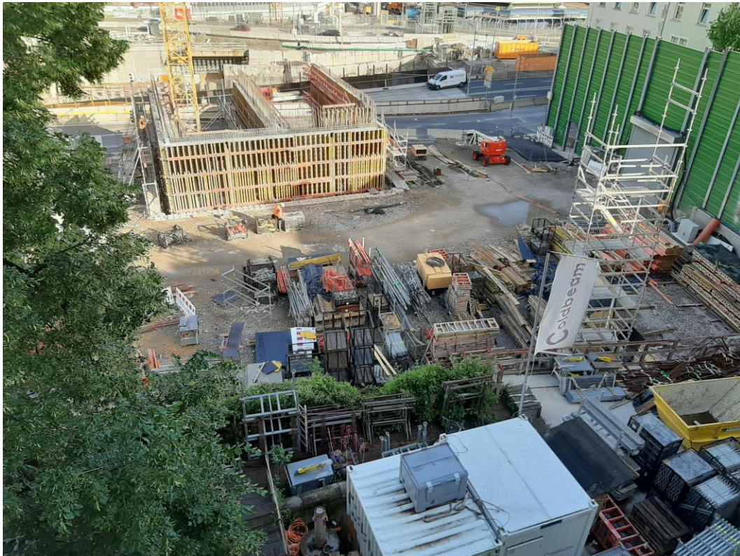
Abbildung 2: Blick auf das Baufeld bei Messende am bis 21.06.2021
