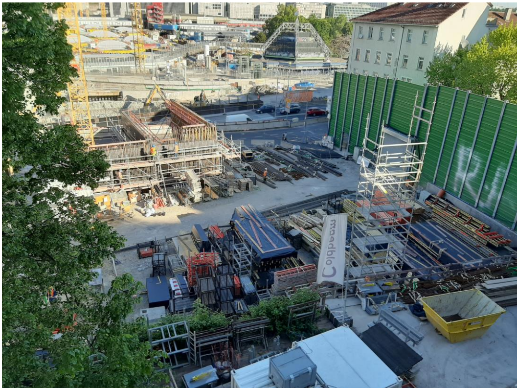
Abbildung 1: Blick auf das Baufeld bei Messbeginn am 31.05.2021
