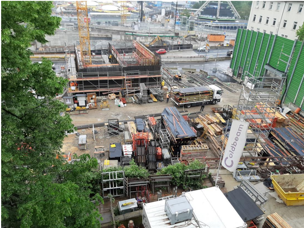
Abbildung 2: Blick auf das Baufeld bei Messende am 07.06.2021
