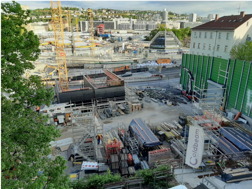
Abbildung 2: Blick auf das Baufeld bei Messende am 17.05.2021
