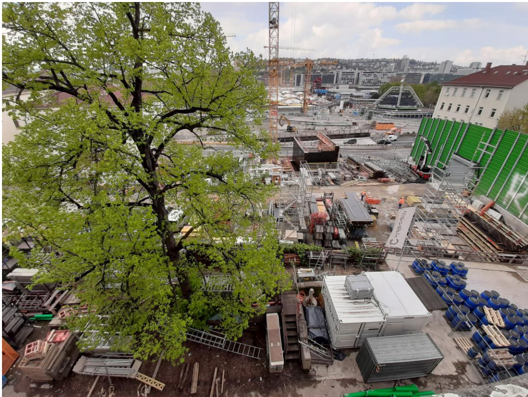
Abbildung 2: Blick auf das Baufeld bei Messende am 03.05.2021
