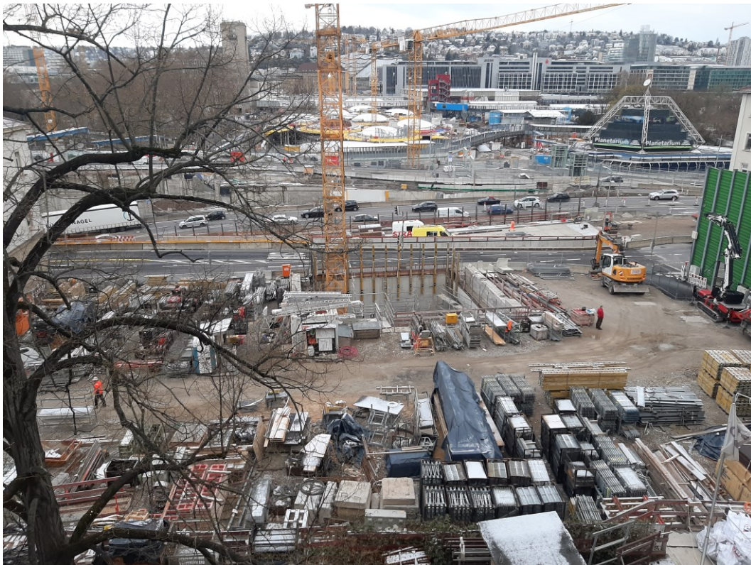
Abbildung 2: Blick auf das Baufeld bei Messende am 05.04.2021
