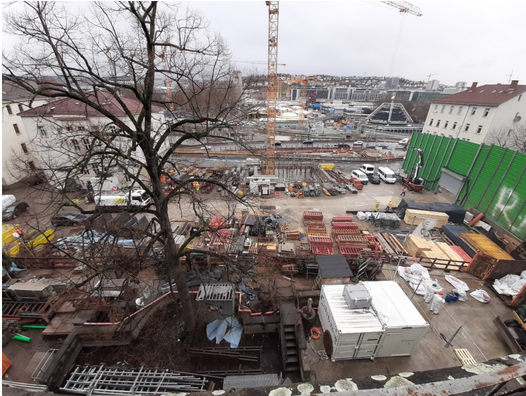
Abbildung 2: Blick auf das Baufeld bei Messende am 15.03.2021
