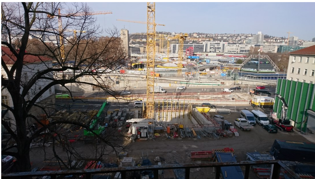
Abbildung 2: Blick auf das Baufeld bei Messende am 22.02.2021
