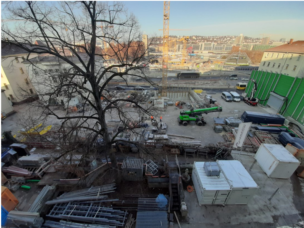
Abbildung 2: Blick auf das Baufeld bei Messende am 11.01.2021
