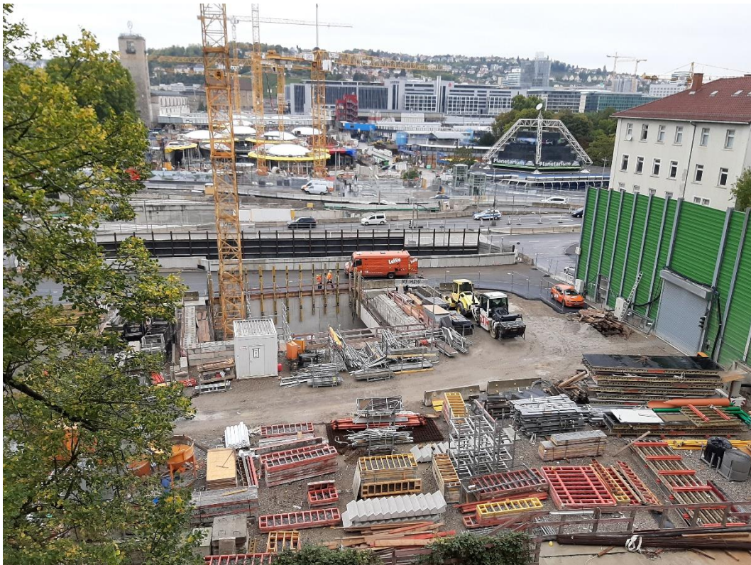
Abbildung 2: Blick auf das Baufeld bei Messende am 12.10.2020
