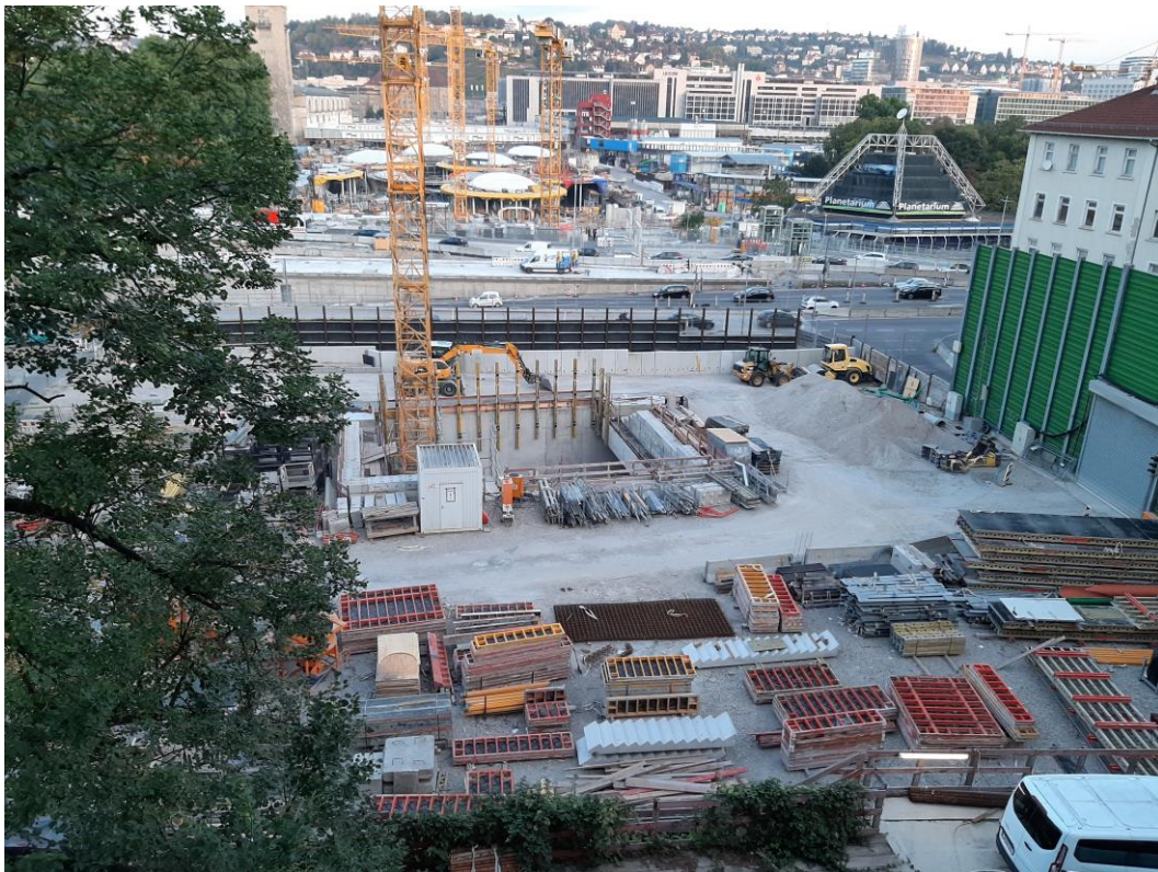
Abbildung 2: Blick auf das Baufeld bei Messende am 21.09.2020
