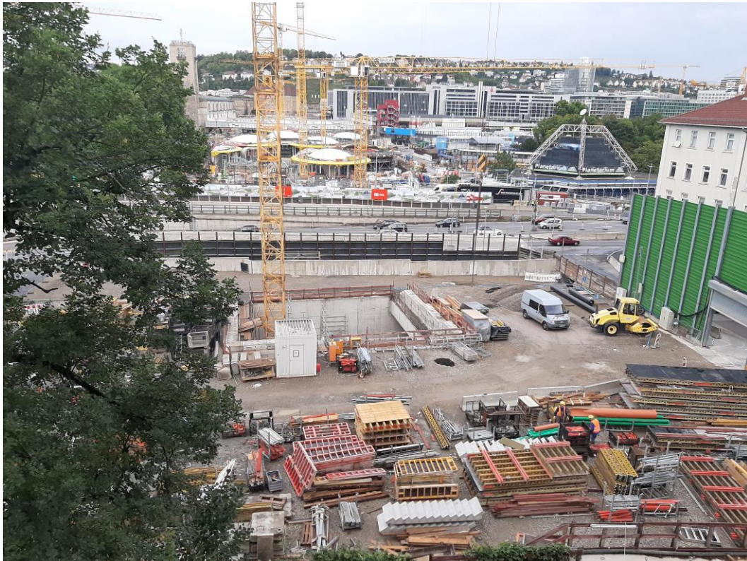
Abbildung 2: Blick auf das Baufeld bei Messende am 31.08.2020
