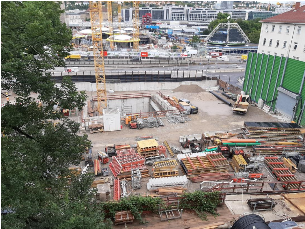
Abbildung 2: Blick auf das Baufeld bei Messende am 17.08.2020
