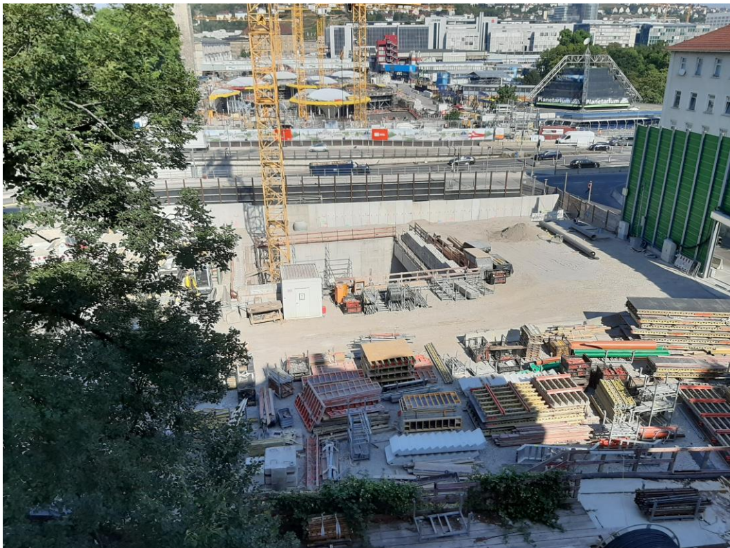
Abbildung 1: Blick auf das Baufeld bei Messbeginn am 10.08.2020
