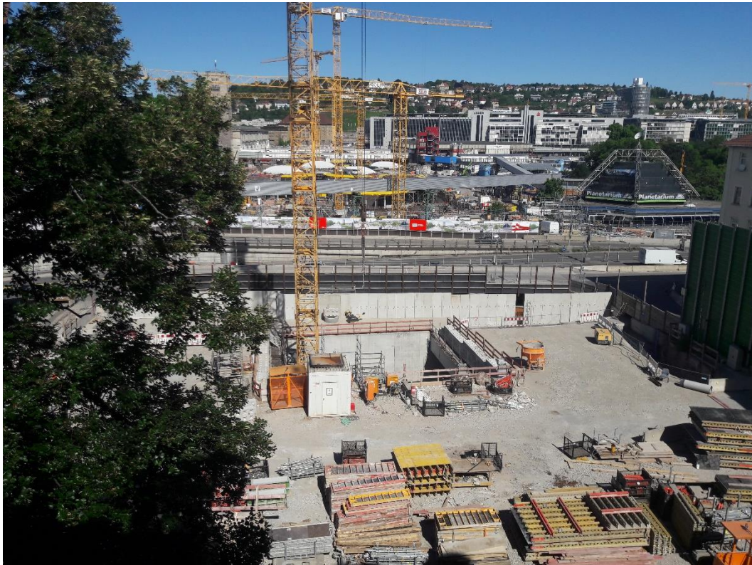
Abbildung 2: Blick auf das Baufeld bei Messende am 09.08.2020
