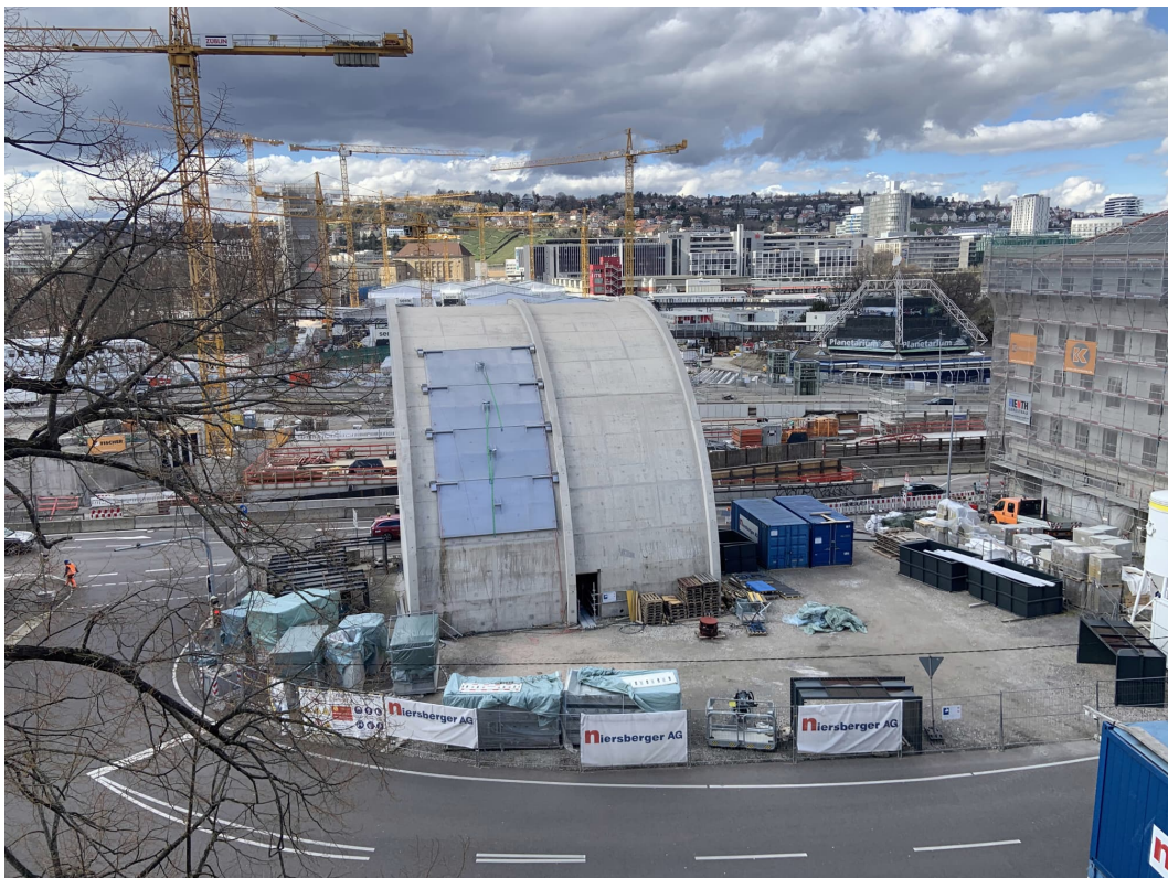
Abbildung 1: Blick auf das Baufeld bei Messbeginn am 02.04.2024
