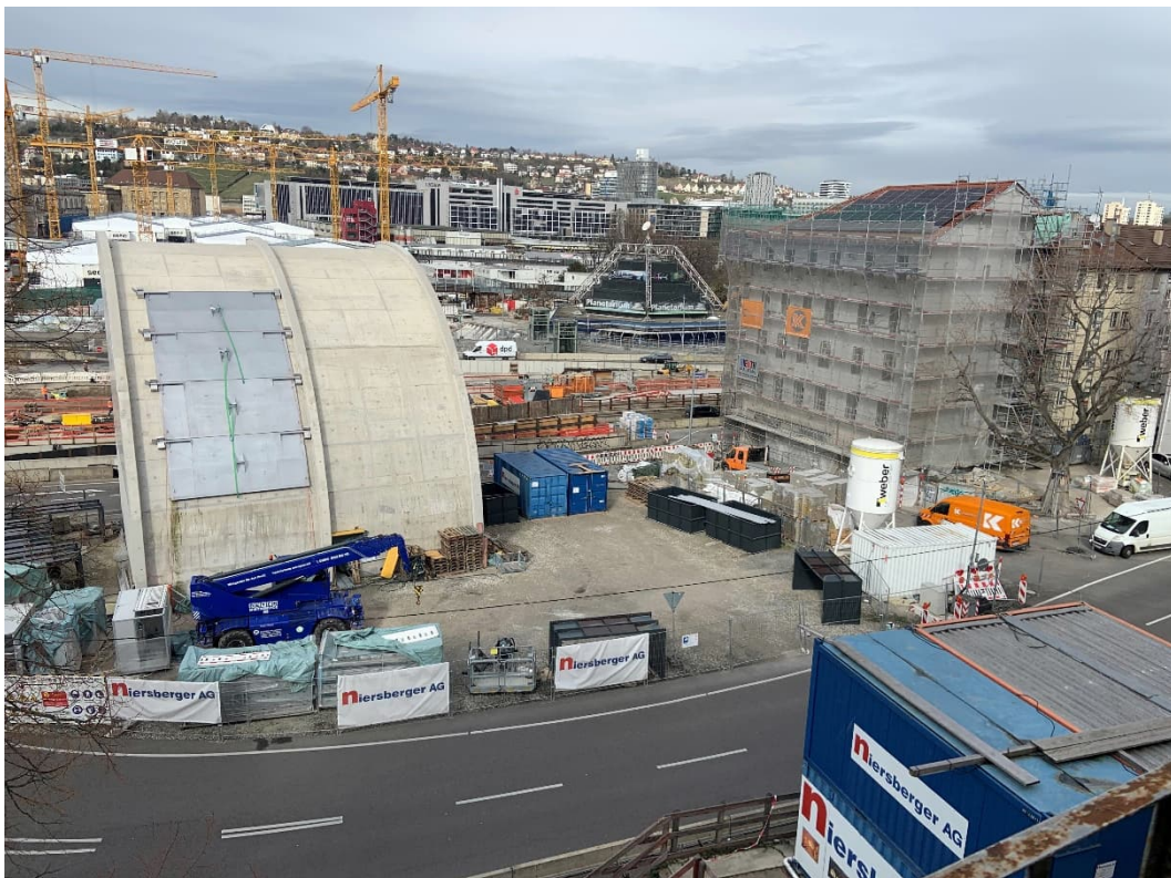
Abbildung 1: Blick auf das Baufeld bei Messbeginn am 26.02.2024
