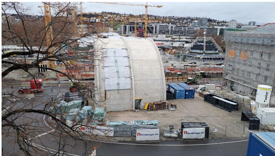
Abbildung 2: Blick auf das Baufeld bei Messende am 21.12.2023
