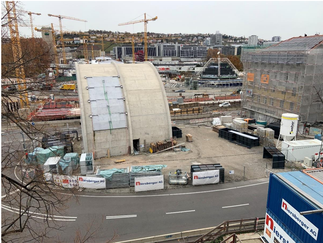
Abbildung 2: Blick auf das Baufeld bei Messende am 27.11.2023
