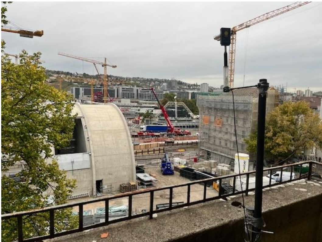
Abbildung 1: Blick auf das Baufeld bei Messbeginn am 23.10.2023
