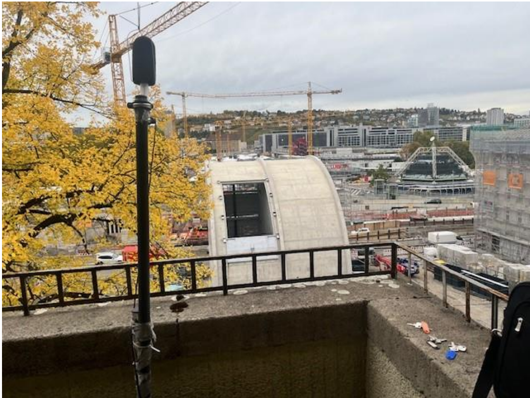
Abbildung 2: Blick auf das Baufeld bei Messende am 30.10.2023
