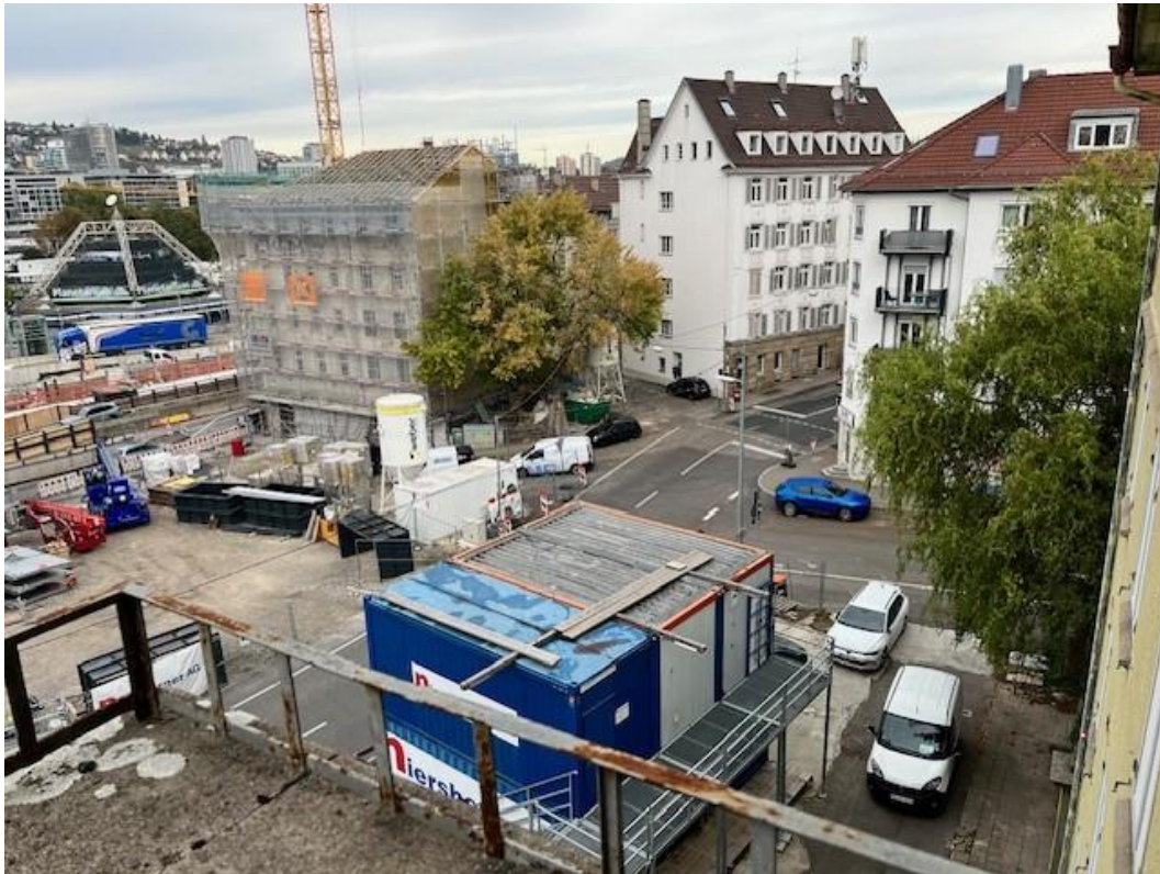
Abbildung 2: Blick auf das Baufeld bei Messende am 23.10.2023
