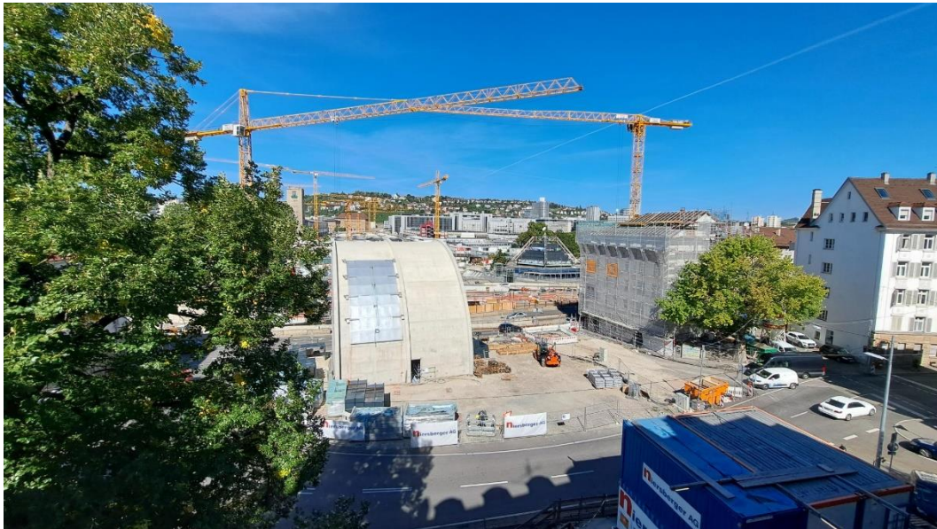
Abbildung 2: Blick auf das Baufeld bei Messende am 04.09.2023
