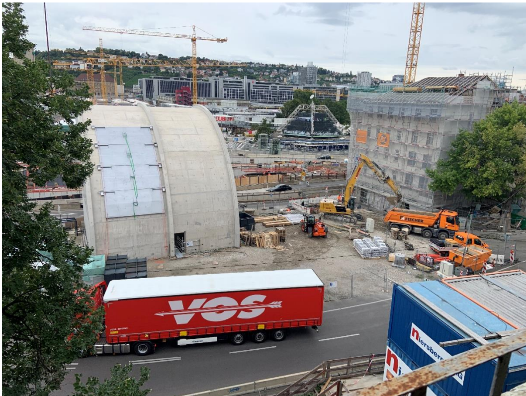
Abbildung 1: Blick auf das Baufeld bei Messbeginn am 28.08.2023
