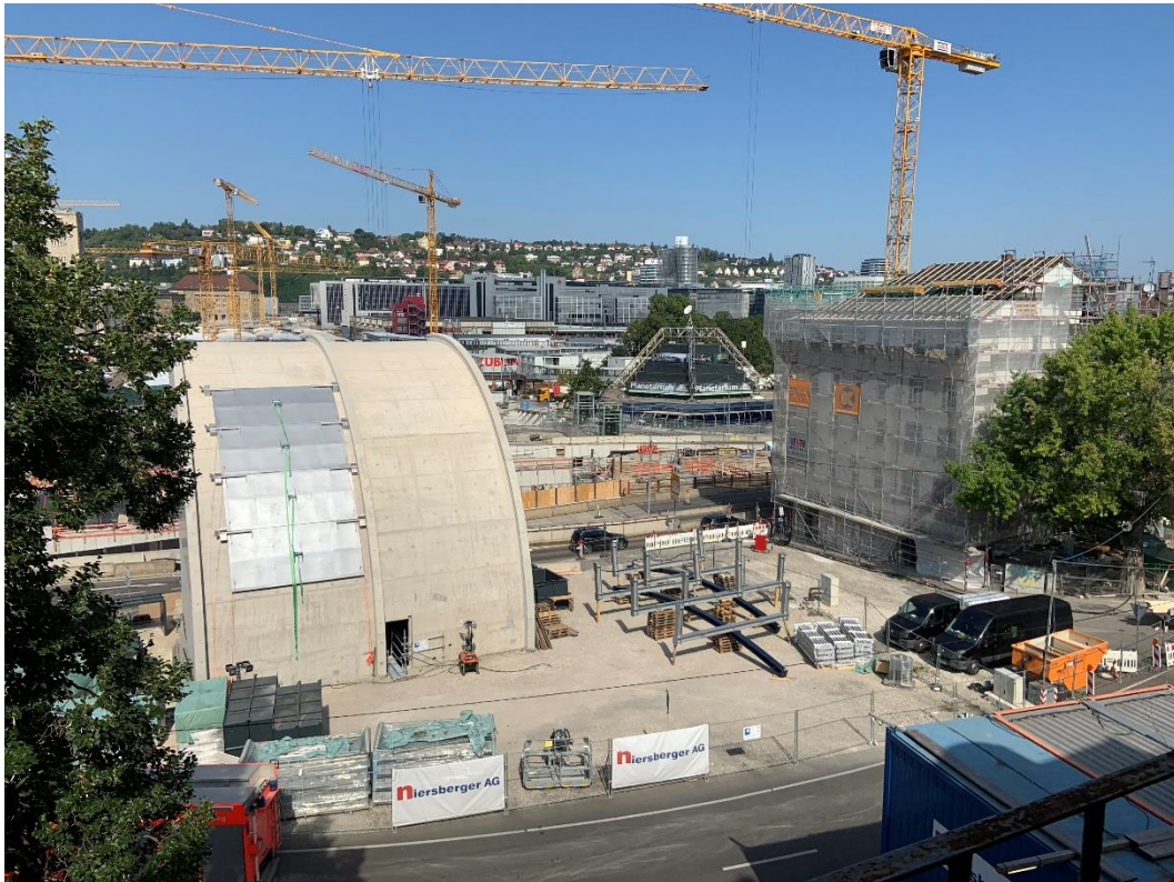
Abbildung 2: Blick auf das Baufeld bei Messende am 21.08.2023
