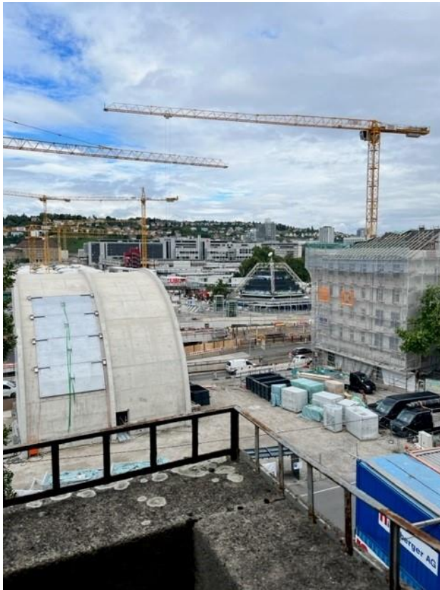
Abbildung 2: Blick auf das Baufeld bei Messende am 07.08.2023
