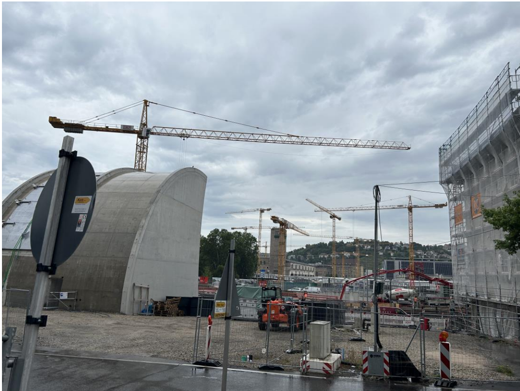
Abbildung 2: Blick auf das Baufeld bei Messende am 24.07.2023
