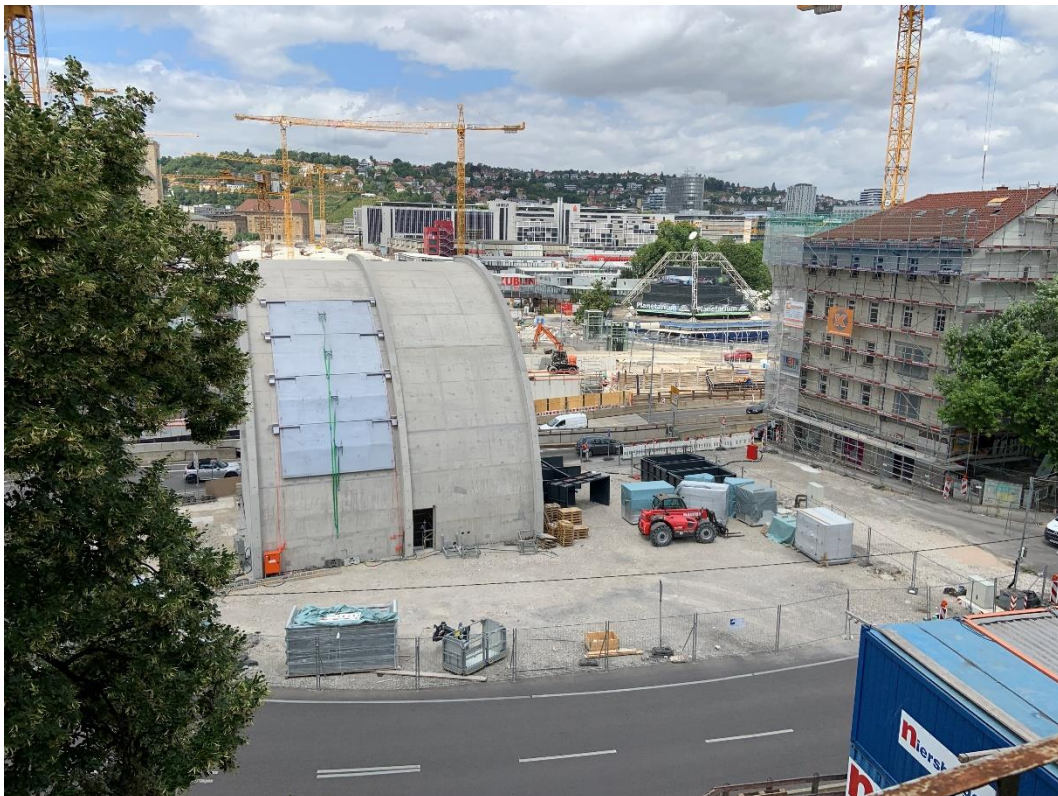
Abbildung 1: Blick auf das Baufeld bei Messbeginn am 03.07.2023
